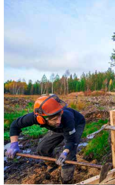
Freiwillige Helfer bauen zur Wiedervernässung von Mooren Stauwände und füllen ehemalige Entwässerungsgräben auf.
